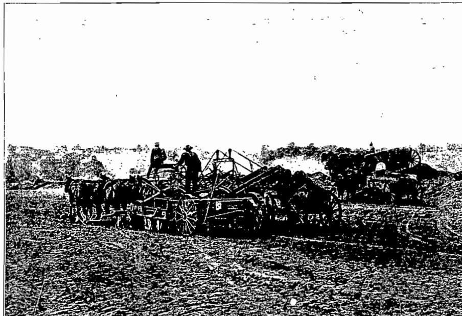
Фиг. 72. Нагрузка подводы при помощи дорожного крана.
