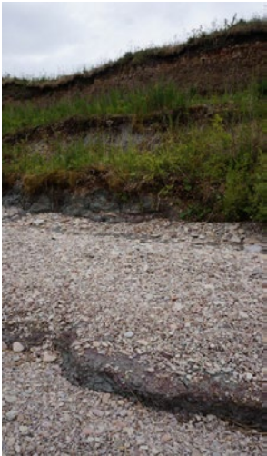
Рис.12. Общий вид оползневого склона на участке I (фото авторов)
