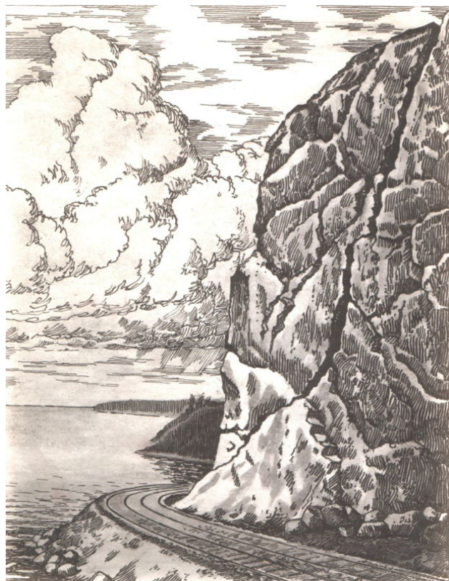
Рис. 3. а) — туннель, сооруженный в скале, отделенной от массива сбросовой трещиной, б) -сбросовая трещина в гранито-гнейсах, отчлняющая часть нагорного откоса (рисунки В. Д. Ломтадзе)
